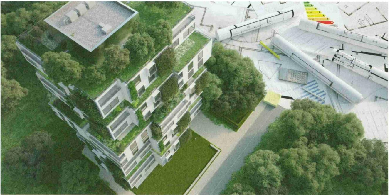
*Messungen zeigten, dass die Oberflächentemperaturen der begrünten Wand um bis zu 13 Grad Celsius niedriger waren als bei unbedeckter Fassade. Hier wird die Begrünung eines Hochhauses schon in die Projektplanung miteinbezogen.*
